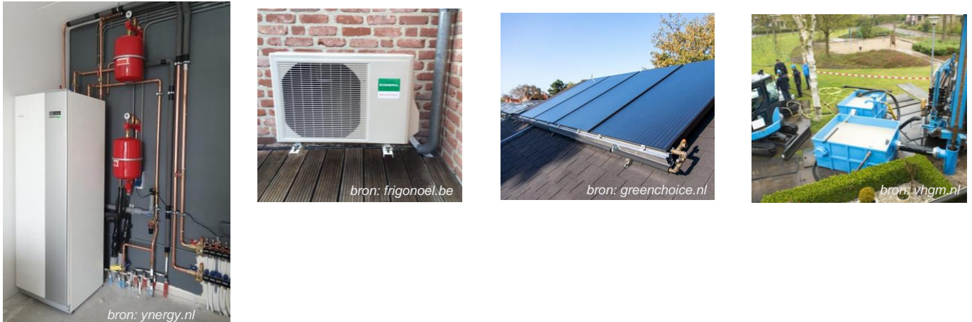
Afbeelding 15 – Van links naar rechts: binnen-opstelling warmtepomp, buitenunit luchtwarmtepomp, PVT-panels, booropstelling voor bodemlus
