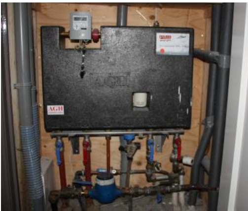
Afbeelding 15 – Afleverset in de woning (bron: statenwarmte.nl)
