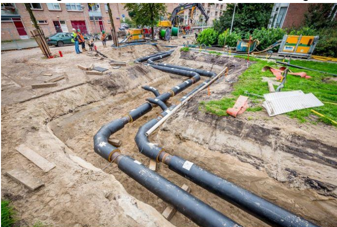
Afbeelding 19 – Voorbeeld van aanleg warmteleidingen in de wijk (bron: ed.nl)
